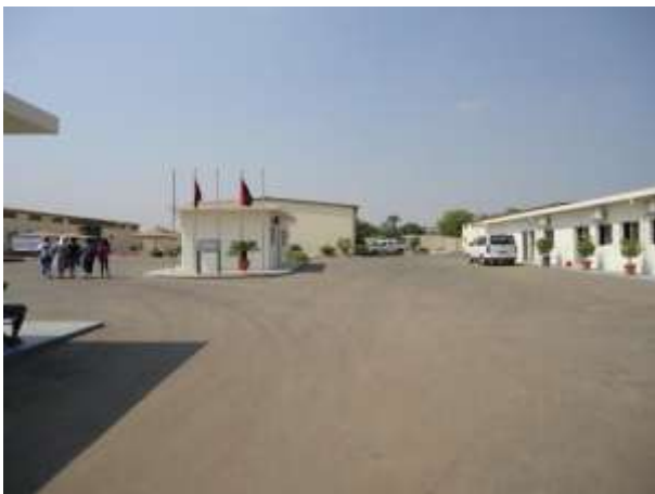
Figura 25: Entrada do Centro de Formação de Quadros Sociais, com o Refeitório do lado direito.
